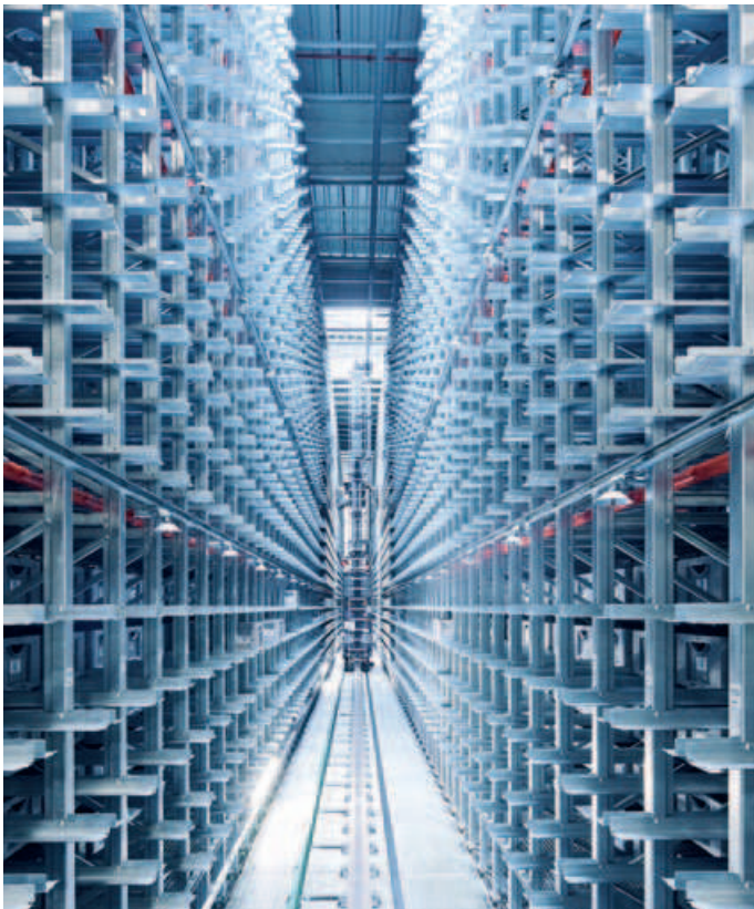
Doppelstöckiges Automatisches Kleinteilelager mit Schäfer Miniload Cranes
