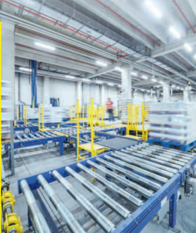
Rund 2,6 km Fördertechnik sorgen für wirtschaftliche Transporte
