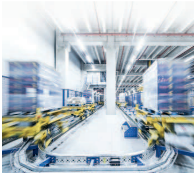
Elektrobodenbahnen verbinden sämtliche Bereiche
