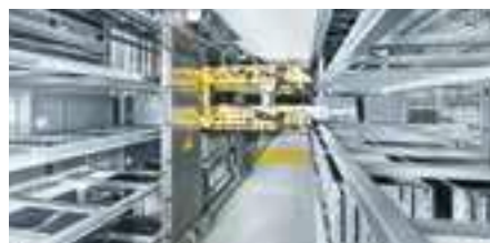
Ein- und Auslagerung durch Navette-Shuttles
