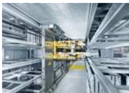
Almacenamiento y desalmacenamiento mediante lanzaderas Navette
