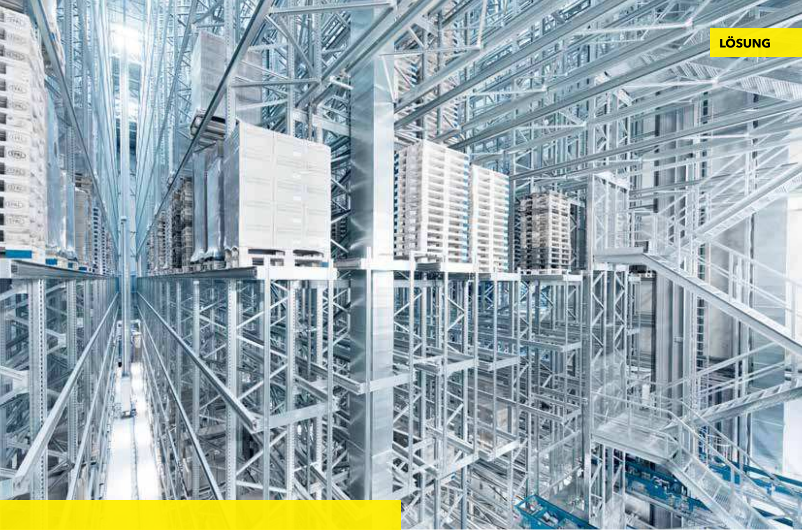
6.300 Paletten finden Platz im dreigassigen Hochregallager
