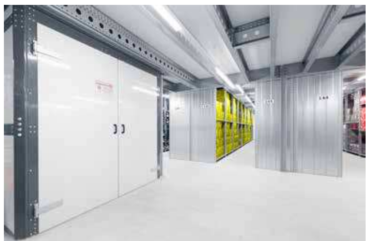
Die komplett schwenkbaren Flügeltüren des Aufzuges erlauben ein schnelles Be- und Entladen.
