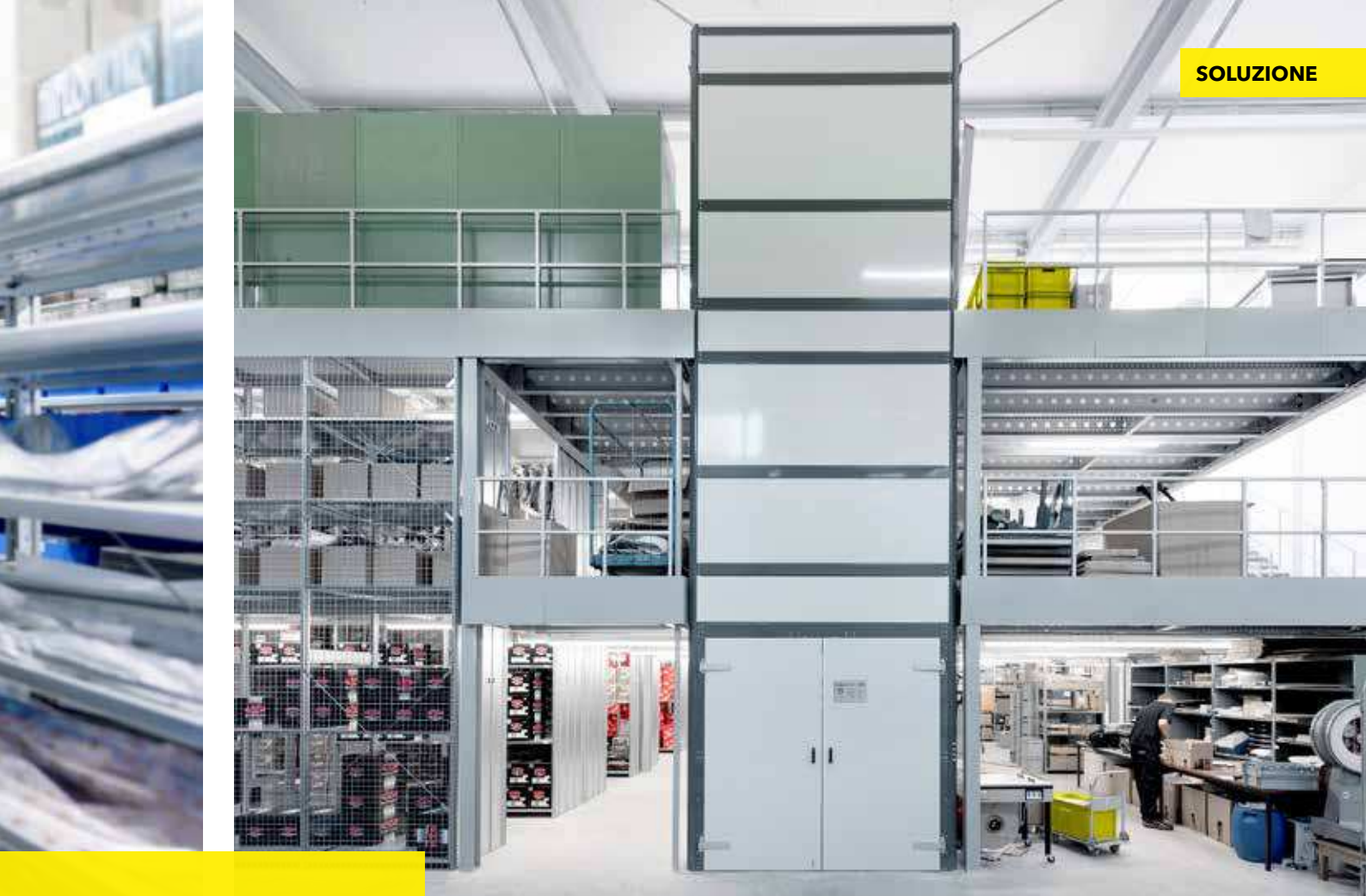
L'elevatore è in grado di trasportare fino a 2.000 Kg su 3 livelli
