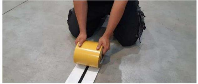
Abb. 3 | Längere Spurelemente kleben
